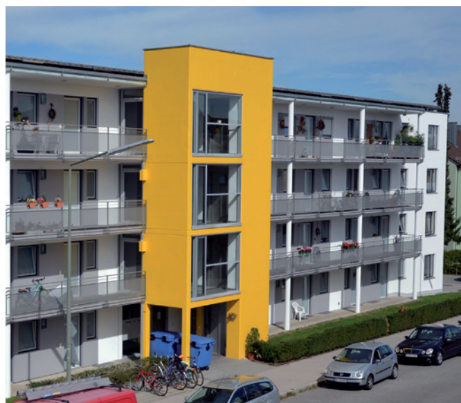
Fast acht Millionen Euro in Summe wurden für Neubauten und für Bestandsmodernisierungen aufgewendet. So z. B. die Maßnahmen in der Vollmarstraße sowie in der Johannes-Hess-Straße . Bei Ersteren wurden unter anderem Außenaufzüge angebaut sowie Fassaden und elektrische Zuleitungen erneuert. In der Johannes-Hess-Straße wurden Außenfassade und Balkone für rund 350.000 Euro erneuert (siehe Bild).
