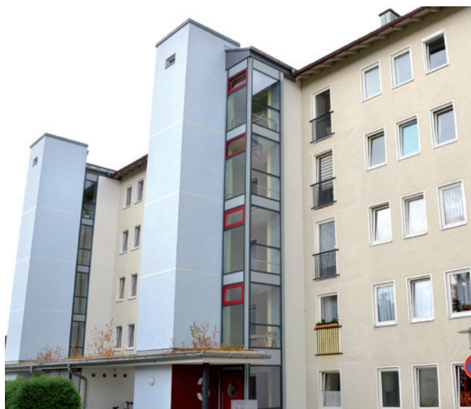
Im August begann der Bau von 26 Mietwohnungen und 49 Tiefgaragenstellplätzen für das Projekt „Wohnen am Stadtpark“. In der Helmontstr. 1 - 3 wurden für Außen-Aufzugsanlagen 450.000 Euro investiert.
