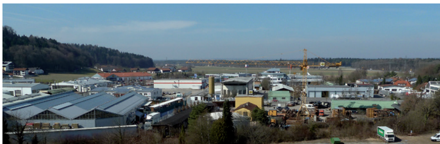
Zahlreiche Fachbetriebe der verschiedensten Branchen finden sich im Gewerbehof Nord an der Burgkichenner Straße..
