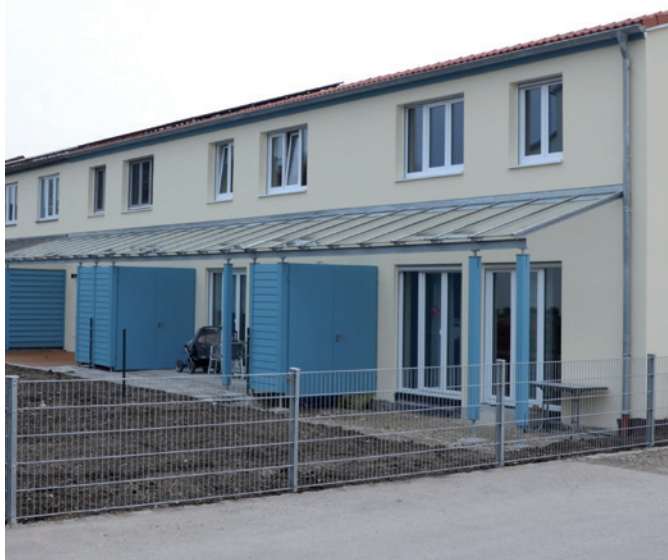
Das Erbbaugelände entlang der Piracher Straße in der Neustadt Burghausens wurde Anfang der 1990er Jahre als Baugebiet ausgewiesen. Die Grundstücke grenzen direkt an das Erbbaugelände „St. Marien“. 21 Reihenhäuser wurden dort neu gebaut. In 2015 (Foto) wurden nachmals fünf Reihenhäuser der BuWoG dort bezugsfertig.
