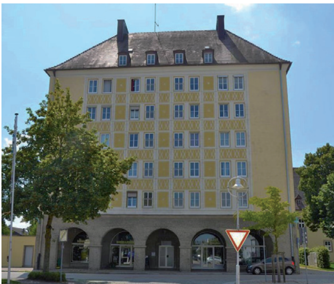
Zwei abgeschlossene Maßnahmen stehen beispielhaft für die Modernisierungsoffensive der BuWoG in den älteren Gebäudebestand: In den Gebäuden in der Wackerstraße, Helmontstraße sowie Hermann-Hiller-Straße wurde eine hochmoderne Heizungsanlage installiert. In der Robert-Koch-Straße 11, dem als „Hochhaus“ bekannten Gebäude, wurde der Brandschutz ertüchtigt und dabei gleich ein neuer Aufzug eingebaut.
