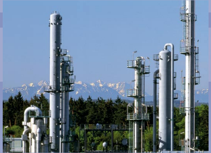
OMV RAFFINERIE OMV REFINERY
